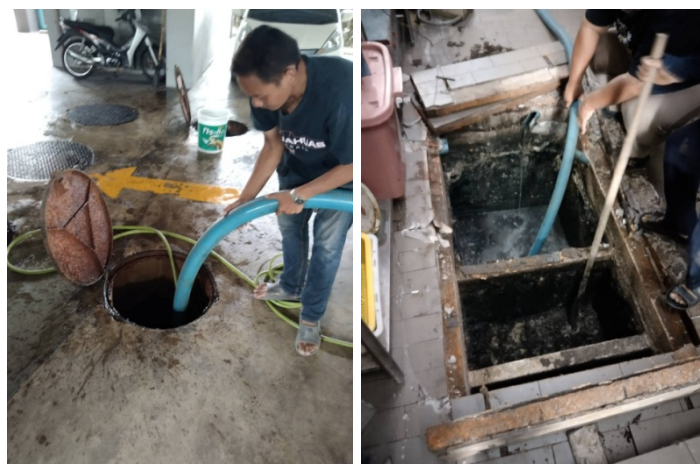
ภาพที่ 4-33 ดูตะกอนปอดเกรอะและปอดักตะกอนที่ระบบบำบัดน้ำเสีย
