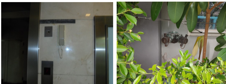
ภาพที่ 4-19 ป้ายทางออกฉุกเฉิน บันไดหนีไฟ และ โทรศัพท์ฉุกเฉินหน้าลิฟต์ หัวรับน้ำดับเพลิงจากภายนอก
