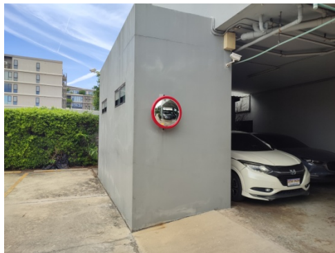
ภาพที่ 4-15 กระงกนุณโค้งไว้บริเวณจุดดับสายตา
